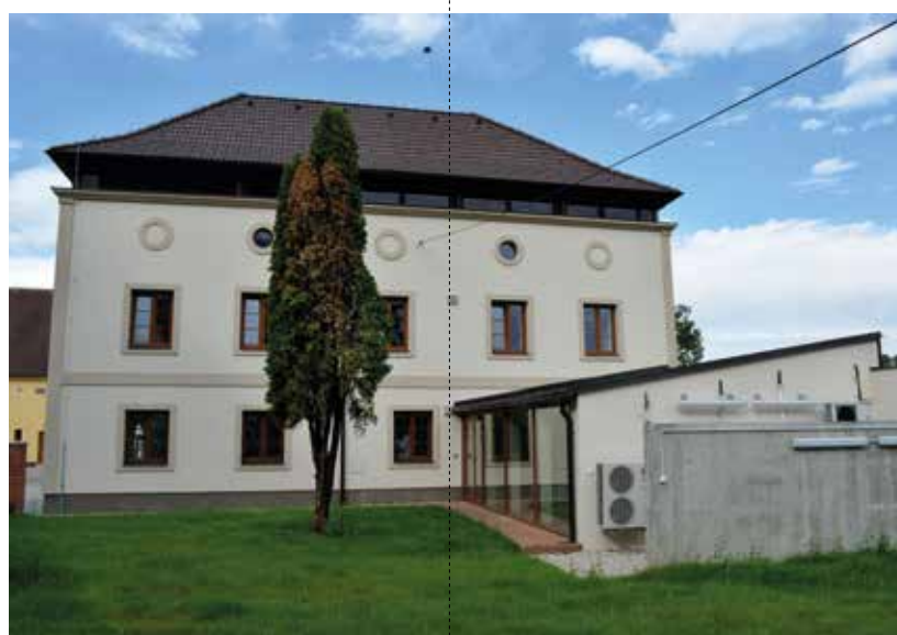
Obr. 5.0: Budova CPE, Česká arktická vědecká infrastruktura „Stanice Josefa Svobody“ (ČAVI SJS) na Svalbardu (Archiv CPE).
