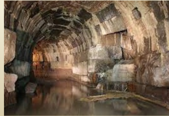
Kanalizace Cloaca maxima Řím
